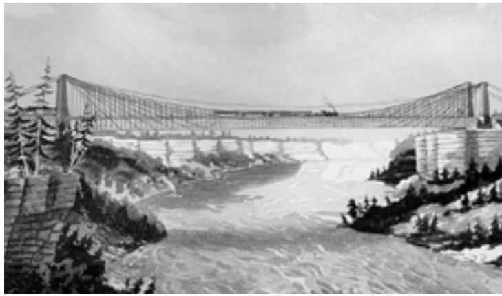
Figura 12. Puente sobre el río Niágara. John A. Roebling 1855
